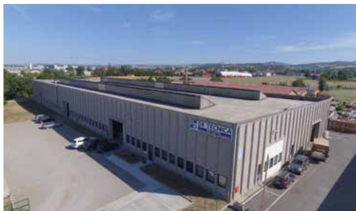
DR TECNICA: VISTA AREA ESTERNA
