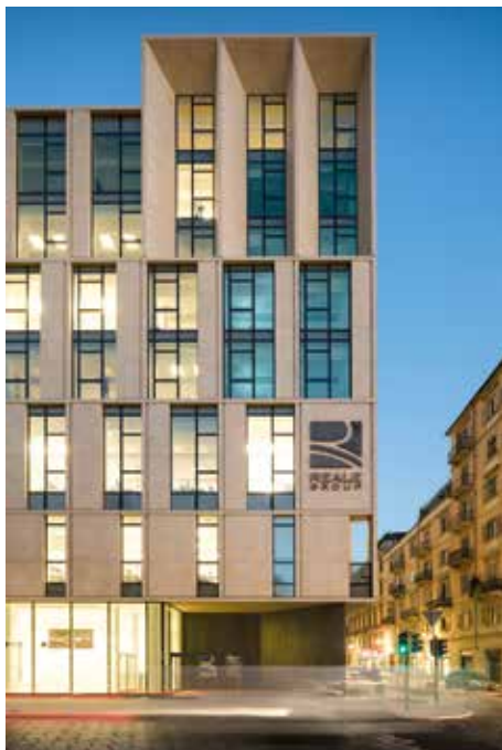
IOTTI + PAVARANI ARCHITETTI E ARTECNA. UFFICI REALE GROUP A TORINO. FOTO: FERNANDO GUERRA | FG+SG FOTOGRAFIA DE ARQUITECTURA.
